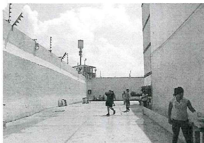
Acceso a patio central
